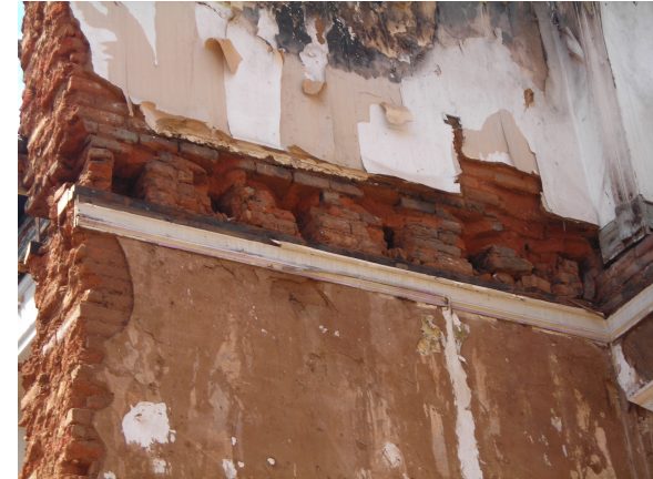
Apoyo de sistema de piso
