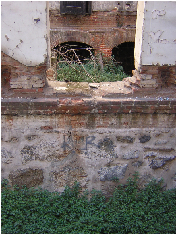
Muros de subterráneo
