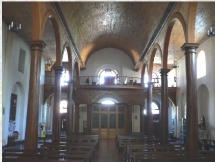
Colonne in legno e volta a botte in listelli di legno
