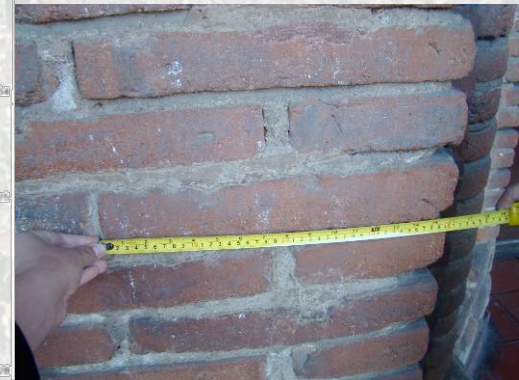
Facciata in muratura di mattoni e malta di calce
