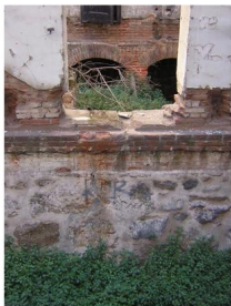
Muros de subterráneo
