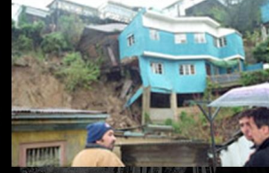
Efectos de coladas de lodo en la terrazas artificiales
