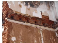
Apoyo de sistema de piso
