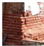
Encuentros de muro
